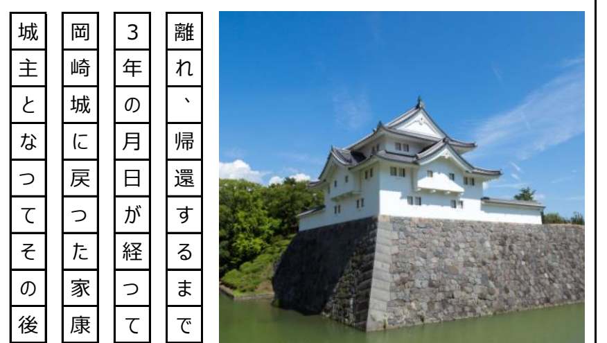
【駿府城】現在は駿府城公園として一般に開放されている。
